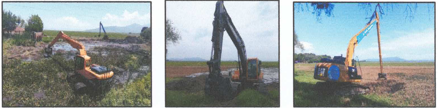
Figura 8. Excavadoras tipo oruga integradas al Programa de extracción de lirio acuático en Presa La Vega.
