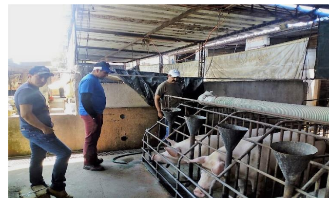
Visitas de inspección en campo para afinar detalles de los sitios ideales de instalación de los biodigestores.
