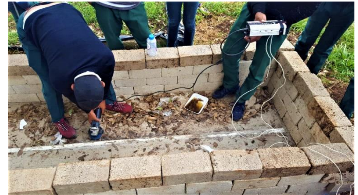
Alumnos del CBTA #230 adecuando el interior de las piletas lombricomposteras. San Juanito de Escobedo, Jalisco.
